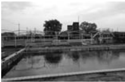
解体予定の甚目寺プール
