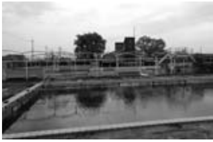
解体予定の甚目寺プール
