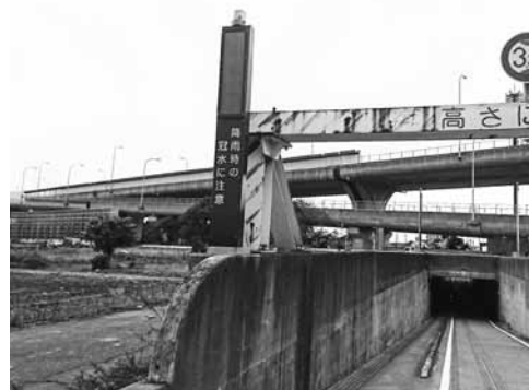
アンダーパスに整備した冠水警報表示施設
