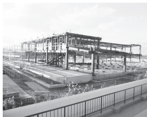
建設中の新学校給食センター
