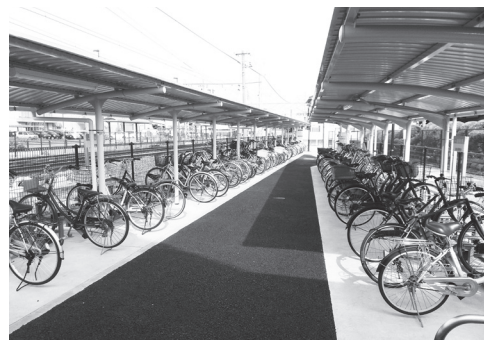
新設した甚目寺駅西側駐輪場
