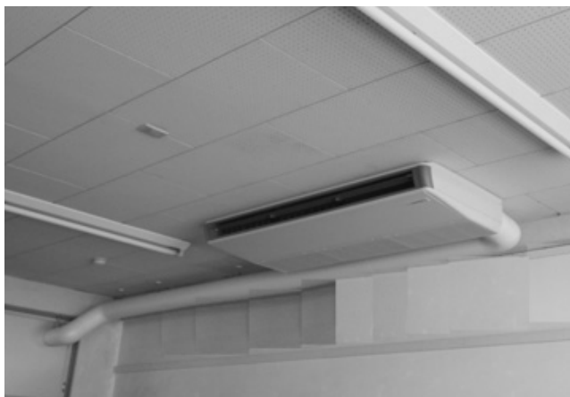
エアコンが設置されました。
