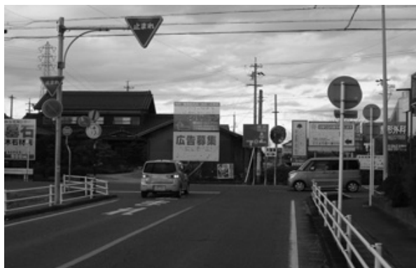
新庁舎整備に合わせ拡幅工事予定の七宝稲沢線
