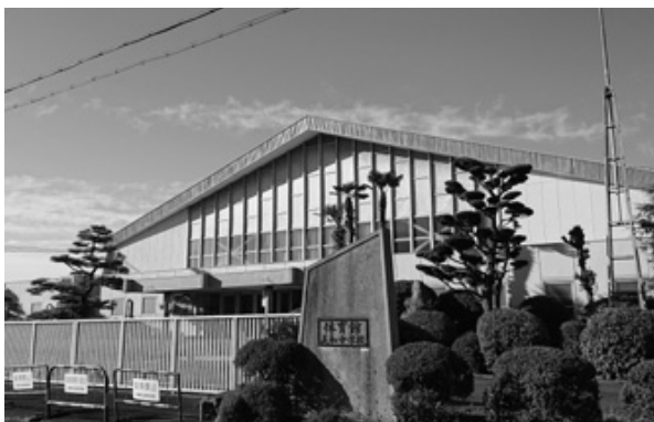
雨漏り対策が必要な美和中学校体育館
