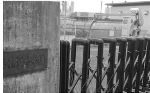
移設予定の碁目寺第一排水機場
