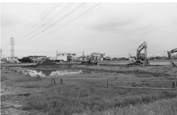
造成工事が進む新庁舎建設予定地
