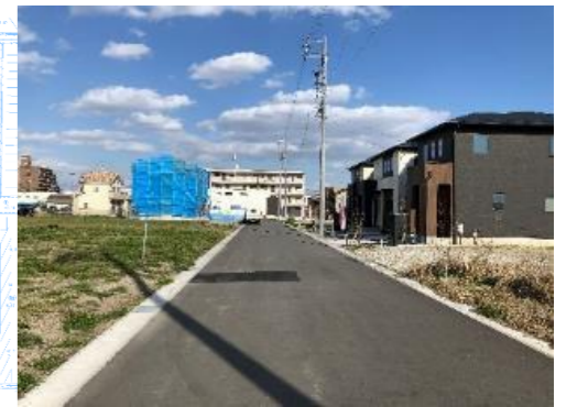
整備済みの区画道路
