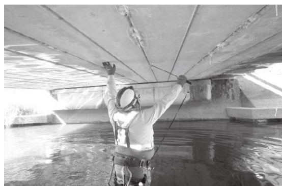
橋梁点検の様子
