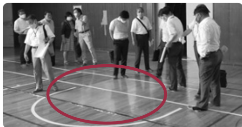
体育館の雨漏りで傷んだ床を張り替えた箇所
