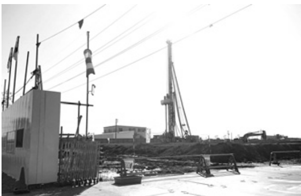
造成工事が進む新庁舎建設予定地
