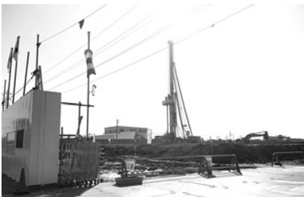
造成工事が進む新庁舎建設予定地
