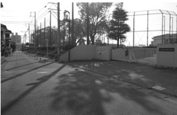
浸水が心配される伊福小学校東側の避難路
