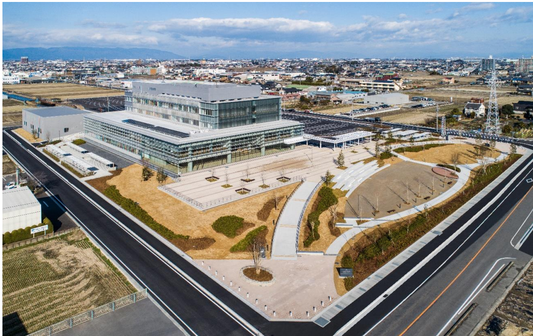
令和5年2月竣工
