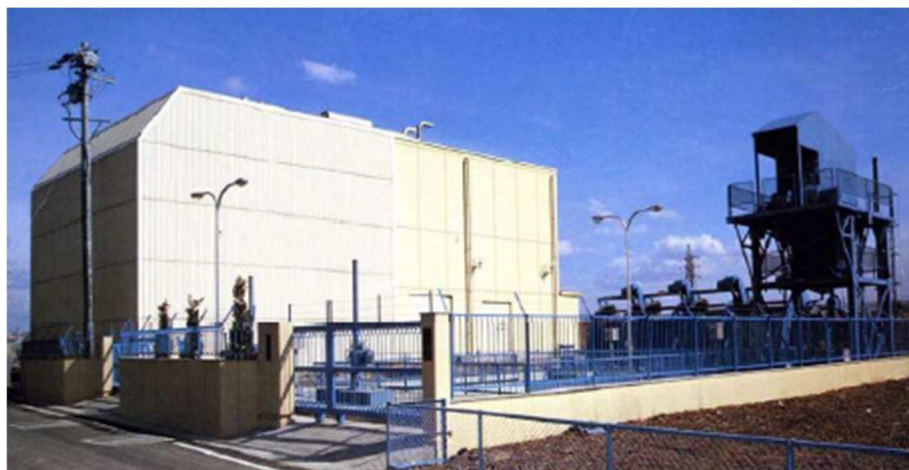
図 4 梶村ポンプ場
