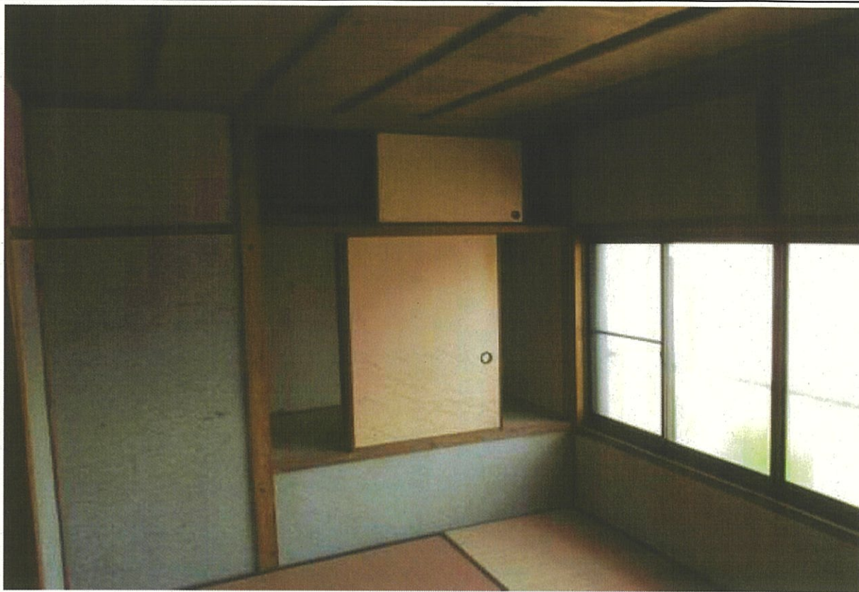
写真⑮（内部 和室 2）
