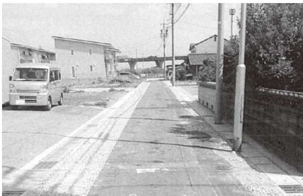
問題提起された側溝新設工事の現場
