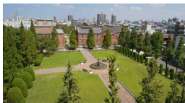
事例写真) ノリタケの森 (愛知県名古屋市)
