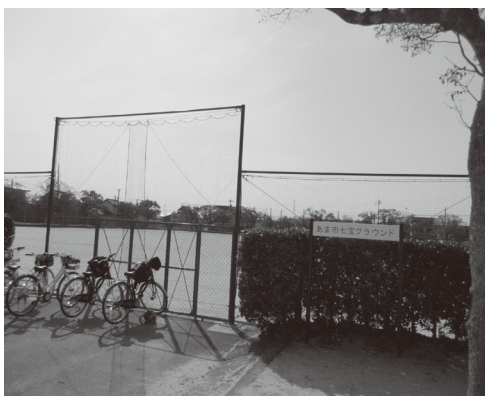
防球フェンスが設置された七宝グラウンド
