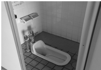
小学校体育館の改修予定のトイレ
