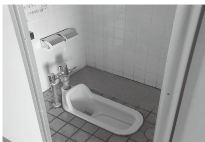
小学校体育館の改修予定のトイレ
