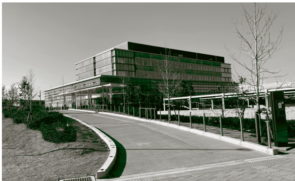
▲北東からみた庁舎棟(令和5年1月現在)
