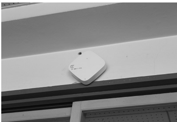
教室に整備されている無線LANのアクセスポイント (篠田小)
