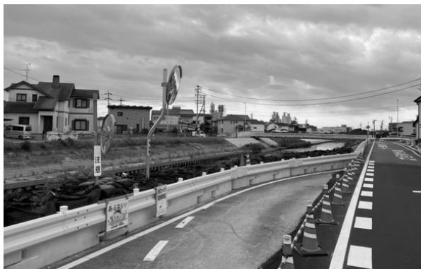
堤防改修工事が進む福田川水道橋人道橋周辺(新居屋区)
