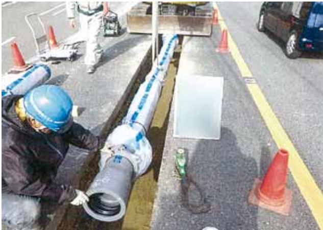
石綿管布設替え工事
