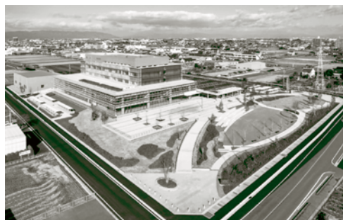
完成した新庁舎
