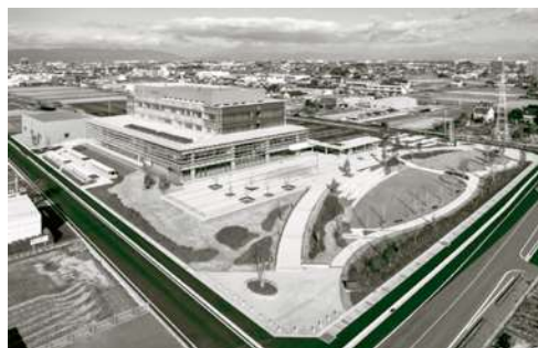
完成した新庁舎
