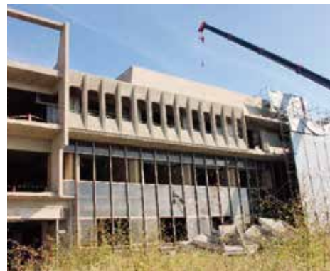
七宝庁舎解体の様子
