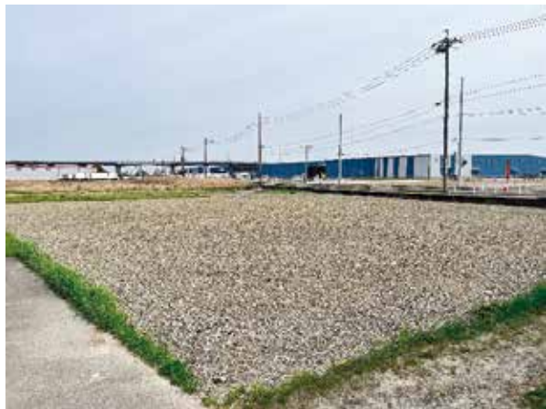
要対策土撤去現場
