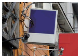
上部構造全体の傾斜、 ぐらつき
