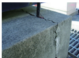
基礎のクラック、支柱と根巻 きとの隙間、支柱のぐらつき
