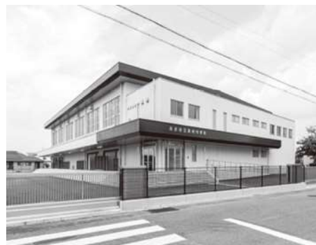
完成した美和中学校体育館
