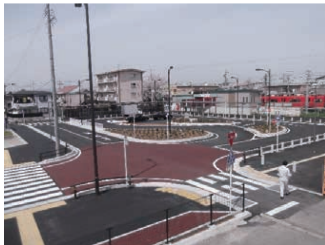
雨水対策がされている木田駅ロータリー
