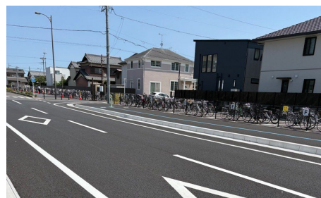
木田駅前線の道路整備
