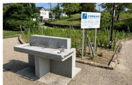
森ヶ丘公園に設置した応急給水施設
