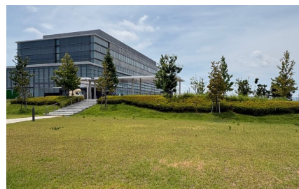
市役所（つどいの広場）
